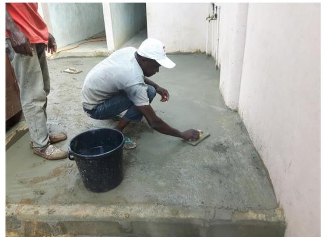
Dalle de béton sur sable et, sous le sable, des roches
